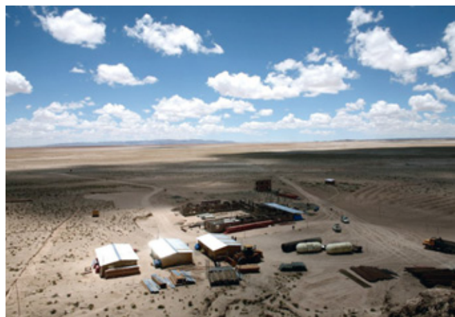
Pilotfabrik: Unweit des Dorfs Rio Grande sind die Gebäude einer Versuchsanlage zur Lithiumgewinnung errichtet worden.
